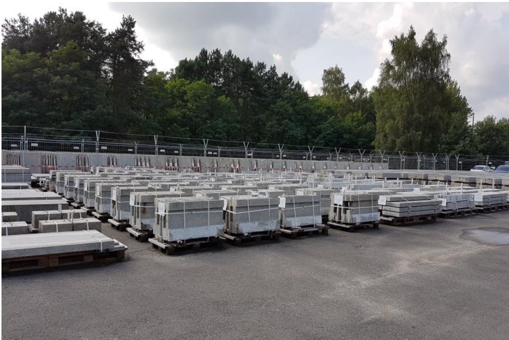
35.000 Originalbauteile, die bauzeitlich oder denkmalpflegerisch wertvoll sind, wurden sorgfältig kartiert, codiert, ausgebaut und in angemieteten Depots eingelagert. Hier das Außenlager mit den Natursteinplatten.
