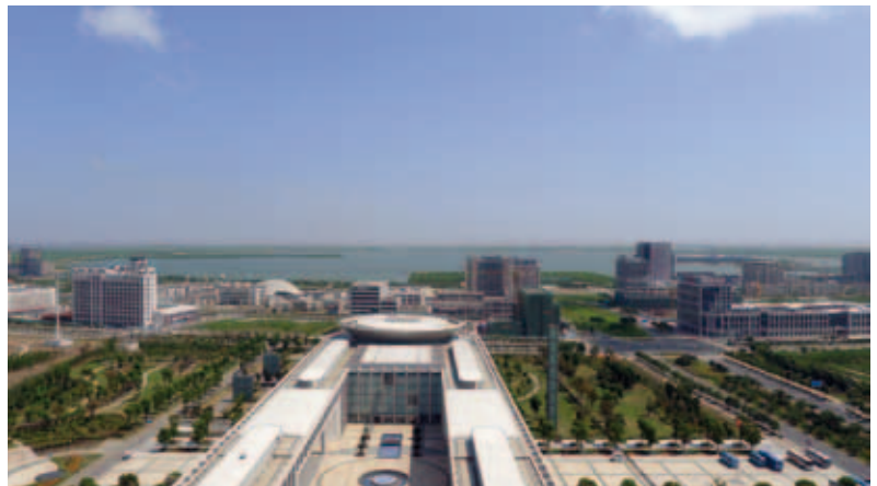
Erster Bauabschnitt, Stand 2011
